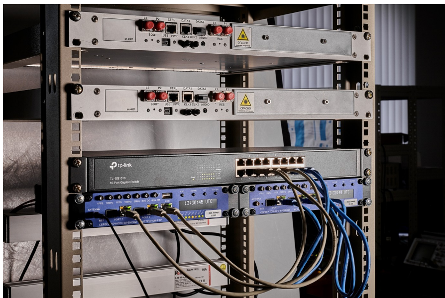
Установка двух серверов на одно место 1U в стойке 19".
